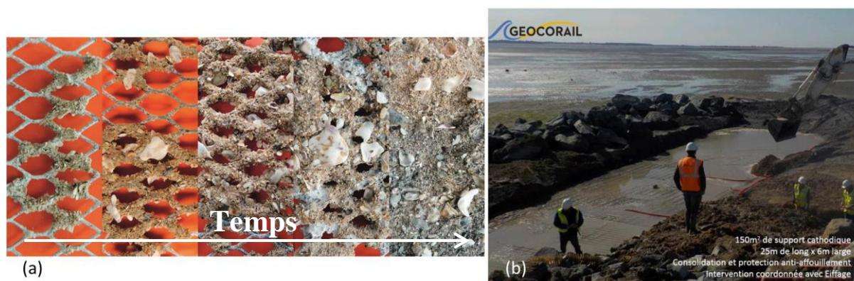
Figure 1 : (a) formation du géocorail® au cours du temps en présence de sédiments ; (b) mise en place de tapis anti-affouillement sous une digue à Yves (17) par Géocorail SAS
